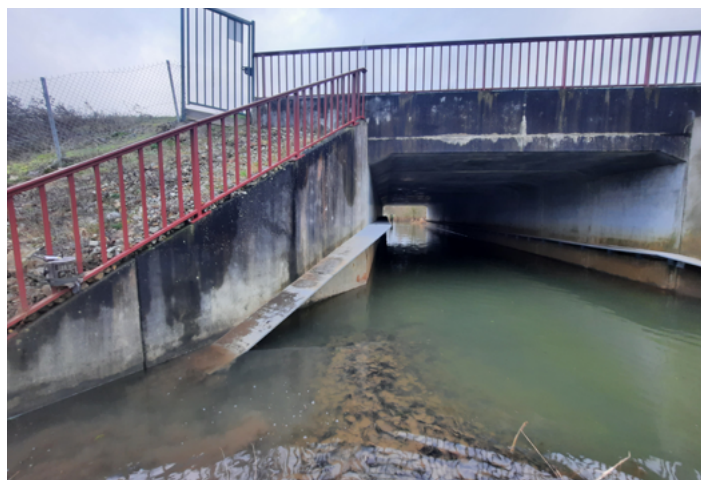
Aménagement sur la Sarthe
