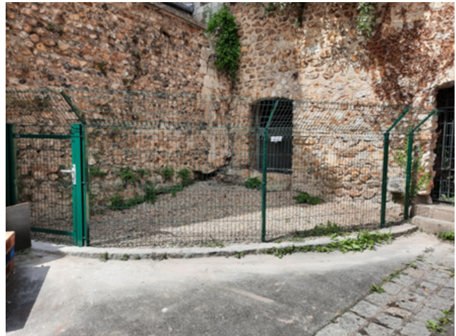
Aménagement grillagé de mise en défens réalisé en 2023 devant l'entrée principale de la cavité
